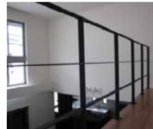
手すり スチール
